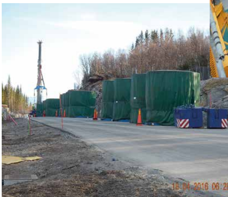
Delkabler forhåndslagres på Øyjord. Ca. 50 tonn/ trommel
