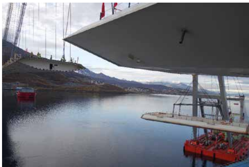
Siste segment heises på plass på Øyjordsiden 06.10.2017, Uglen fra Ugland gjør siste løft, det er en milepæl i prosjektet og tommel opp
