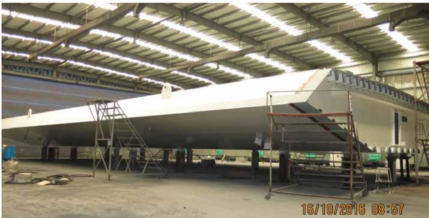
Her er en seksjon ferdig overflatebehandlet, hver seksjon er 40M lang vekt ca 250 tonn.
