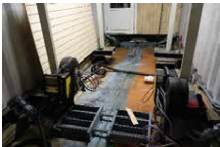
Bildet viser sveising av kjørebanelen, 14mm plate.
